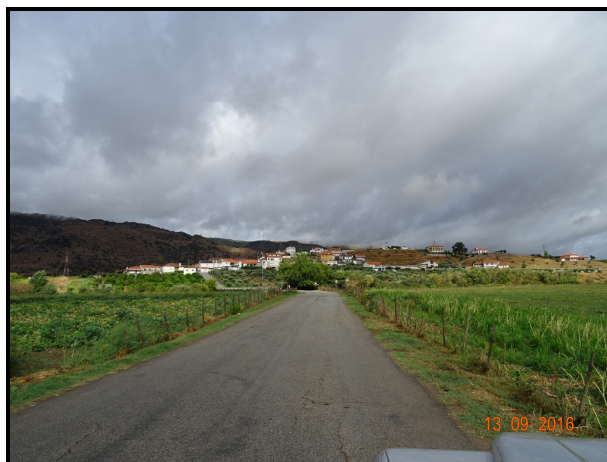
Acesso à plataforma do miradouro M2
